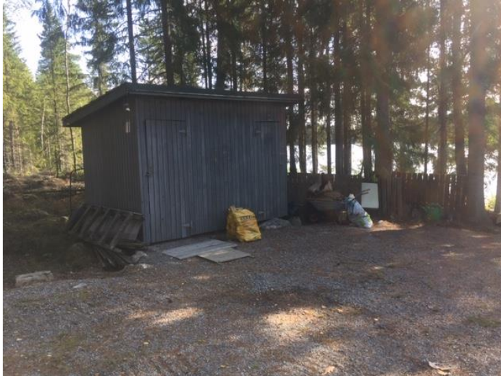
Bild 6. Förråd på fastighet 1:95, tomt 1
