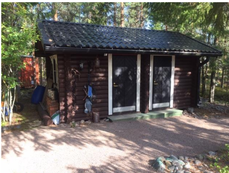
Bild 11. Förråd på fastighet 1:164, tomt 4
