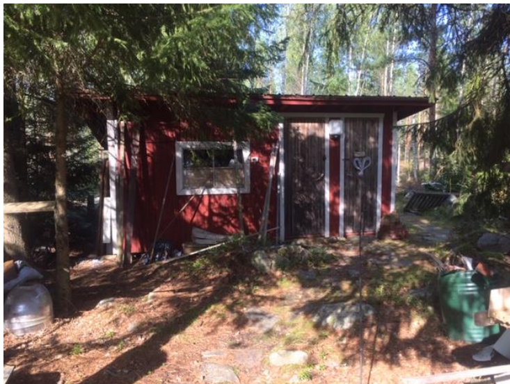
Bild 7. Förråd på fastighet 1:58, tomt 3
