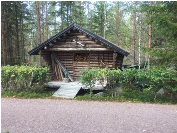
Kuva 10. Lato kiinteistöllä 1:164, tontti 4
