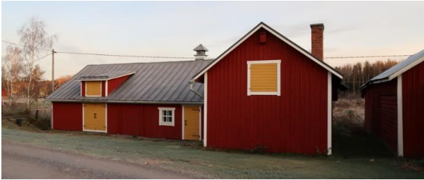
Gårdsbyggnaden från söder.
