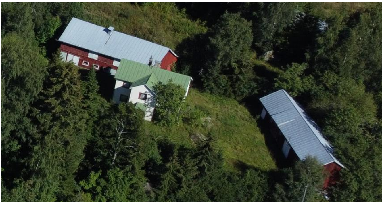
Gårdsområdet från sydost.
