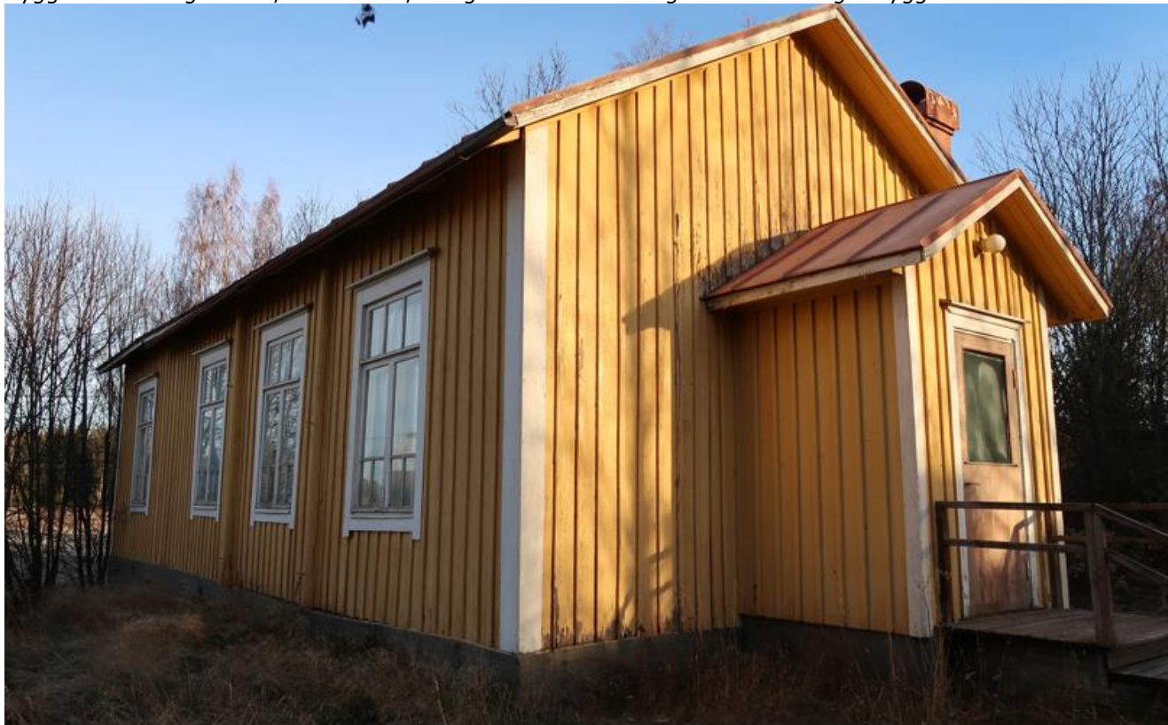
Byggnaden sedd från sydsydväst.
