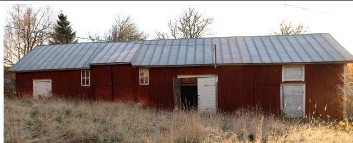
Gårdsbyggnad i östra delen av fastigheten.
