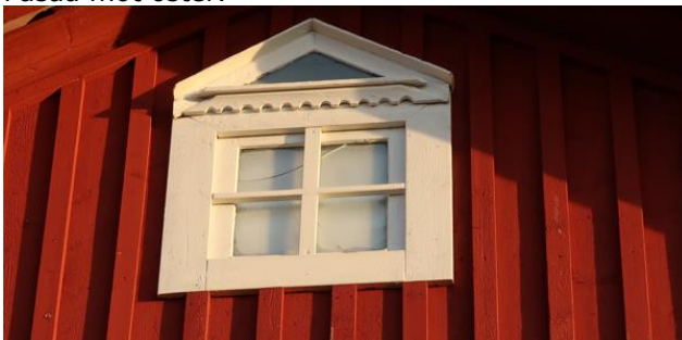
Den södra gavelns vindsfönster
