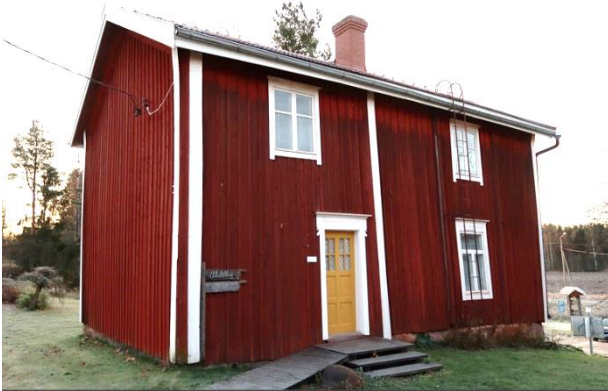
Fasad mot väster.
