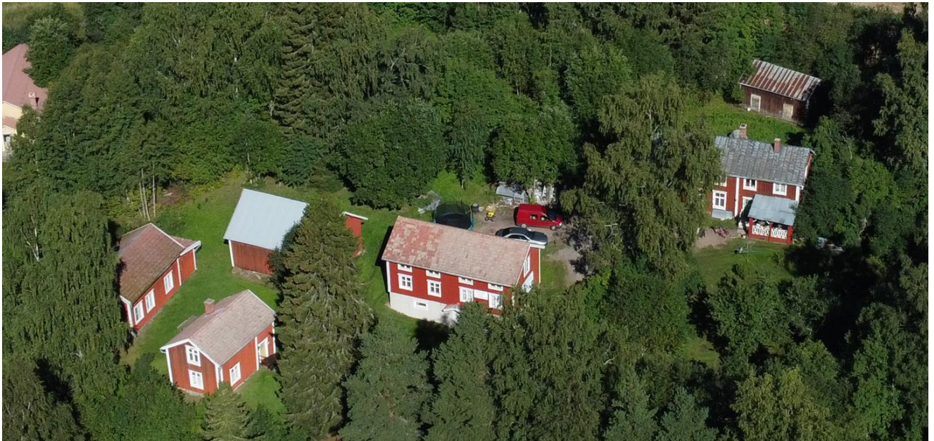
Fastigheten sedd från söder. Närmast finns Johan Storms stuga (2), i mitten hantverksateljén och längst bak till höger bostadshuset (1). Längst till vänster finns Brita Härtulls stuga som hör till museibygggnaderna.
