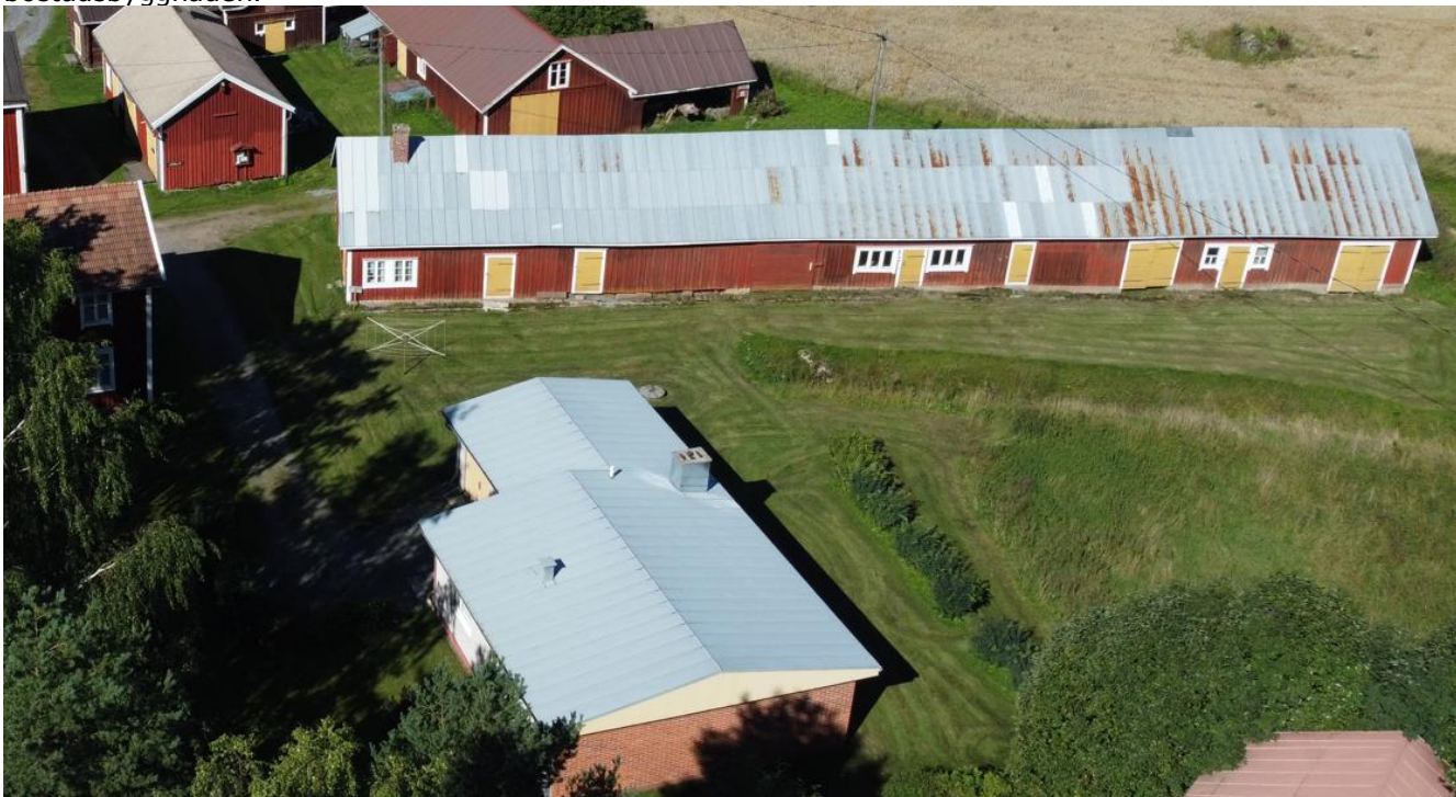
Byggnadsgruppen fotograferad från öster, i förgrunden den nyare bostadsbyggnaden, längre bak den gamla gårdsbyggnaden.
