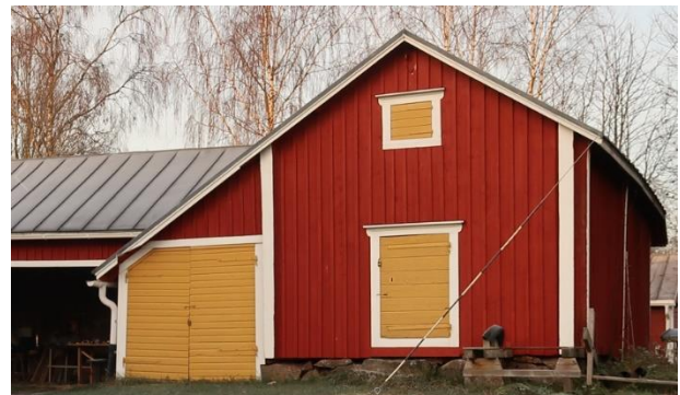
Gårdsbyggnaden med långknutar har ursprungliga dörrar och har huvudsakligen ribbpanel.
