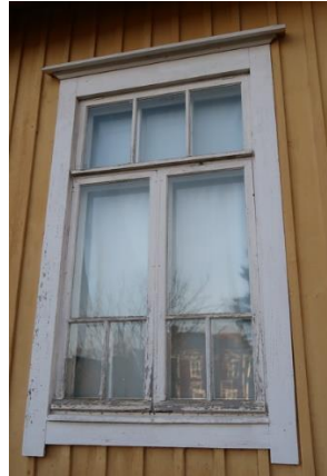
Fönster från väster.
