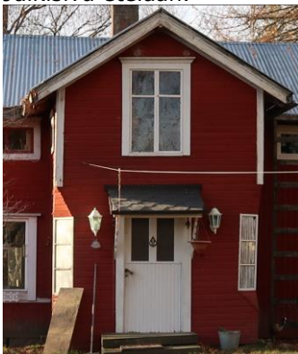
Kuistin viistetyissä nurkissa on ruutuikkunat.
