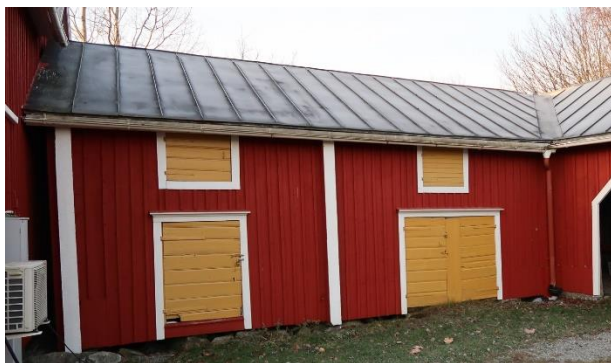
Piharakennuksen ja päärakennuksen välissä on kapea väli. Katto liittyy kiinteästi päärakennukseen.
