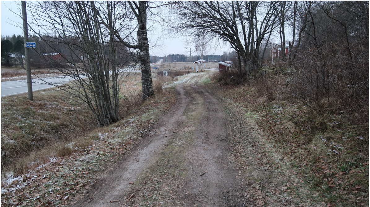
Kuva 19. Valtatien vieressä kulkevaa vanhaa maantietä idän suunnasta.
