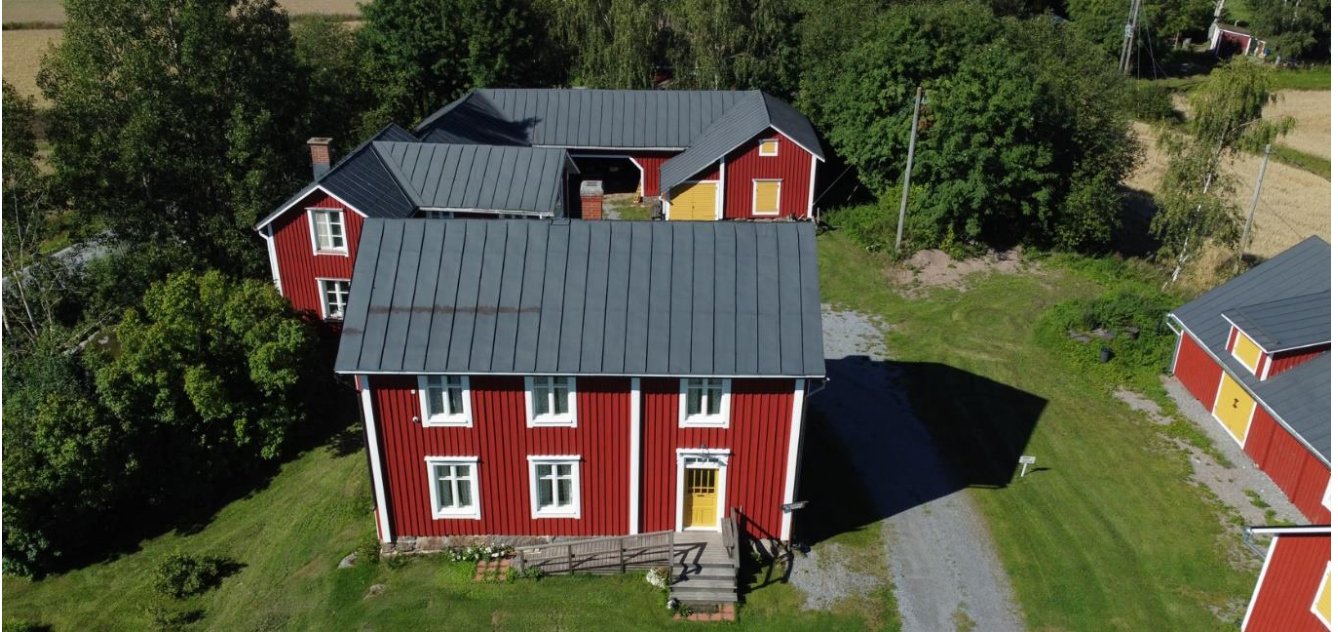
Rakennus on etualalla, kuva otettu idästä.
