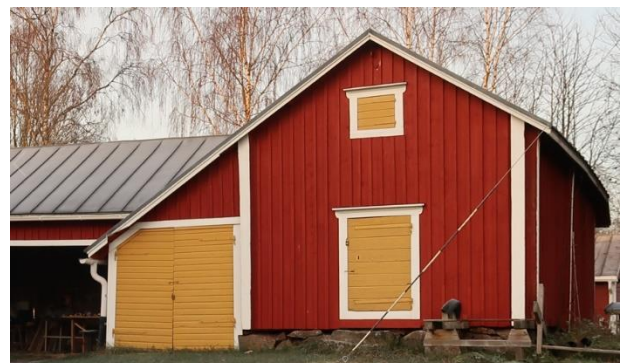
Pitkänurkkaisessa piharakennuksessa on alkuperäisiä ovia ja pääosin rimoitettu lautaverhous.
