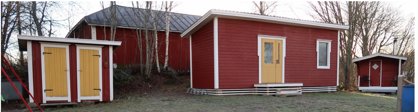
Piharakennukset sijaitsevat kiinteistön itärajalla.
