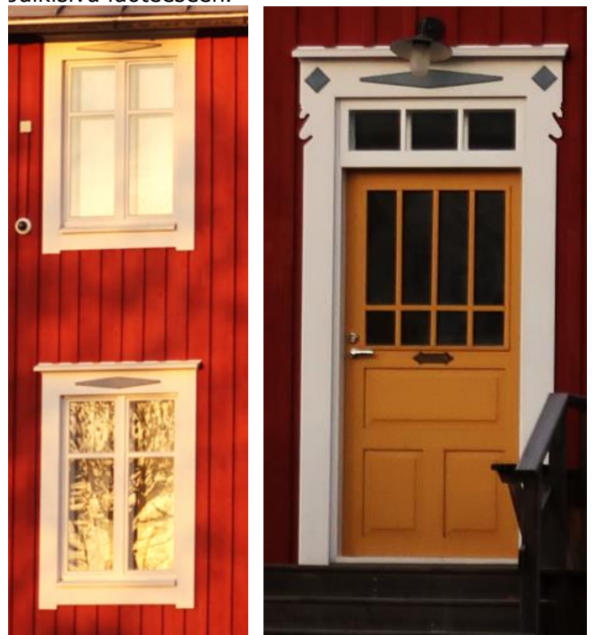
Ikkunoiden ja oven yksityiskohdat.
