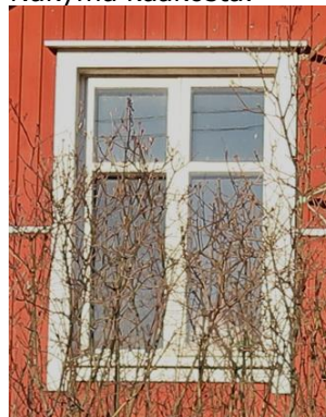
Rakennuksessa on alkuperäisiä tai vastaavilla uudemmissa korvattuja ikkunoita.
