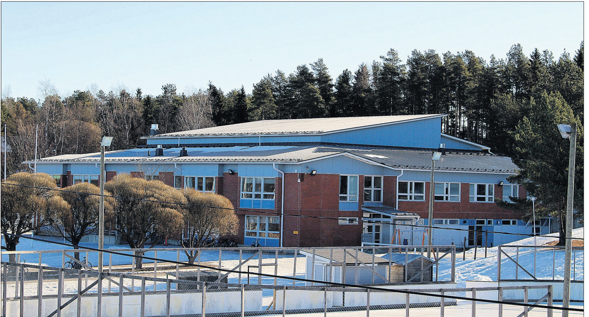
Ännu återstår en del småfixande som kommer att utföras under våren och försommaren men i det stora hela är projektet avslutat.
