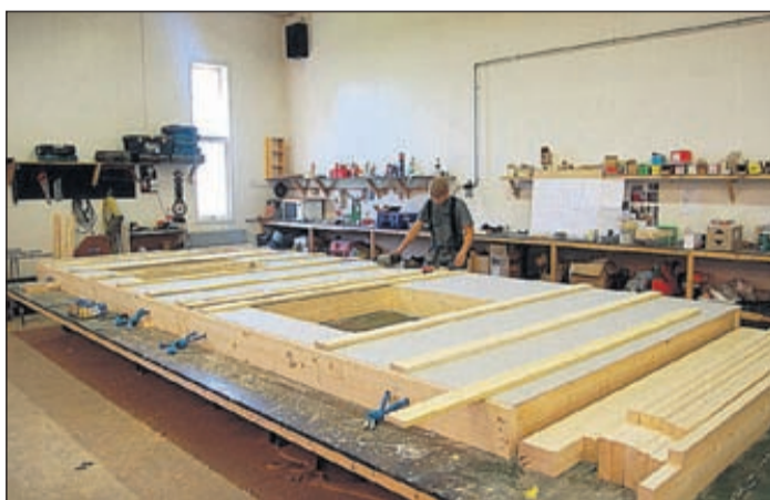
Här arbetar Tomas Engström med att isolera en vägg.
