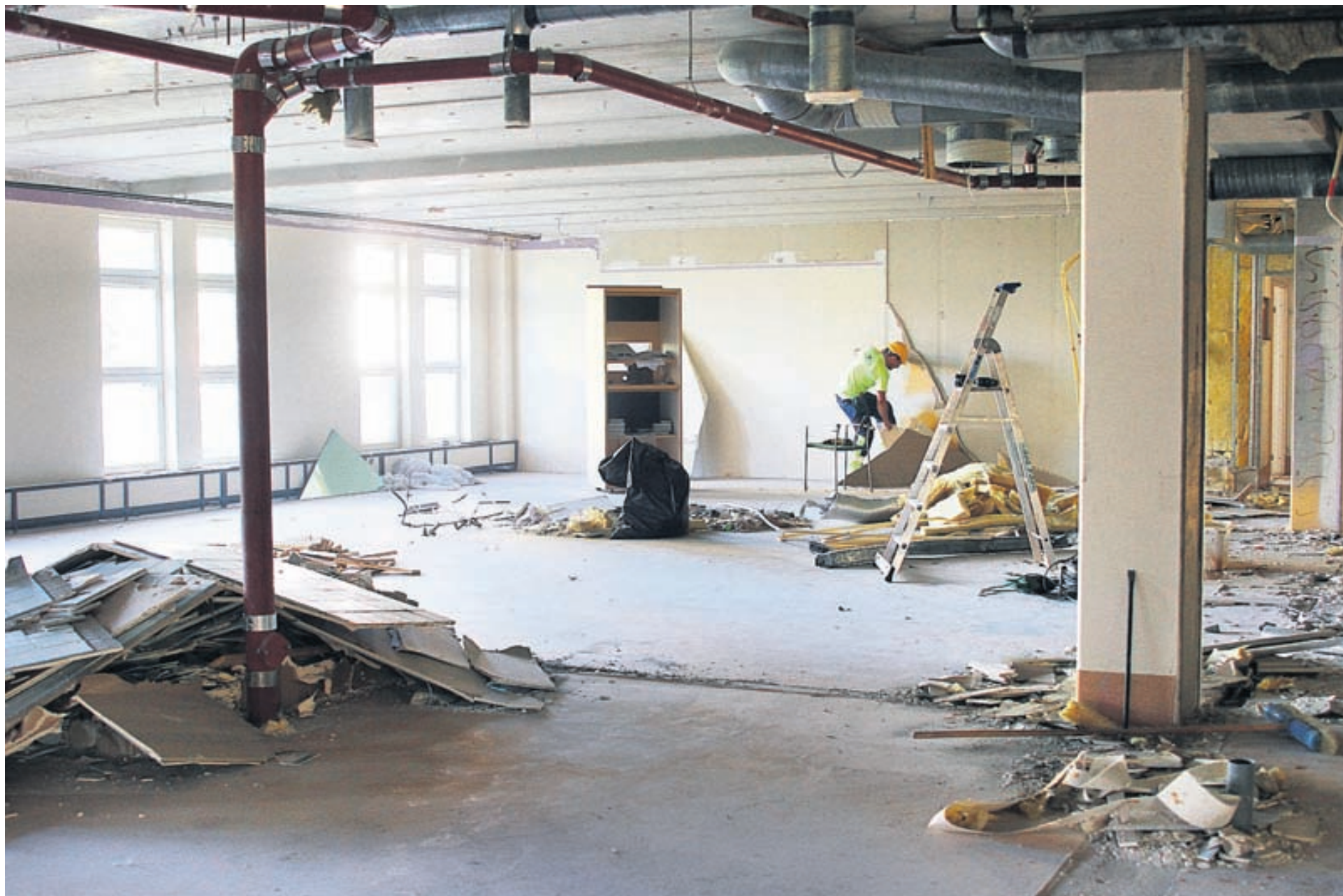
Här ska gymnasiet flytta in. På denna yta kommer ett klassrum att finnas vägg i vägg med ett rum där de studerande kan umgås och läsa på tenter. Rören i taket rivs bort och takhöjden blir den som syns på bilden. De nya rören kommer att målas vita för att smälta in eller döljas av kornischer. FOTO: ANNA GAMMELGÅRD
