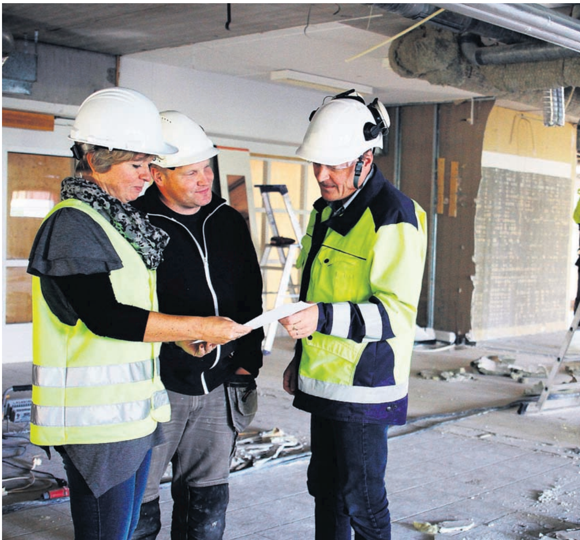
Rektor Nina Karls-Nygård, arbetsledare Tommy Martin från huvudentreprenören MWM Bygg och tekniska chefen Jan Östman i det blivande gymnasiet. I bakgrunden Christian Wikman som river rör.
